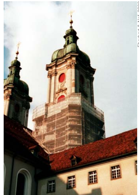
Abbildung 3: Das im Auftrag der Arge «Gerüst Kathedrale» durch die Nüssli Schweiz AG, Hüttwilen, ausgeführte Gerüst (August 2002)
