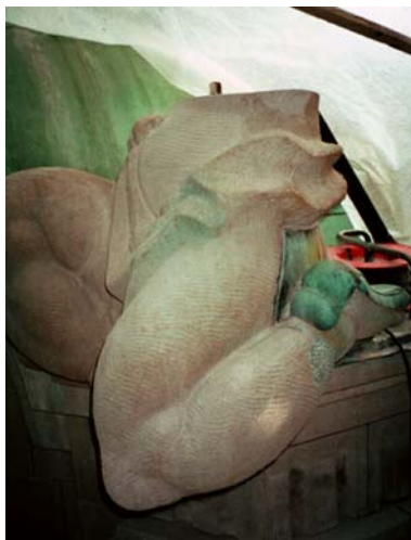
Abbildung 9: Der untere Teil der linken bekrönenden Putte des Tympanons wurde reprofiliert (links), der obere musste in der Bildhauerei von Walter Ghenzi in Uznach abpunktiert werden
