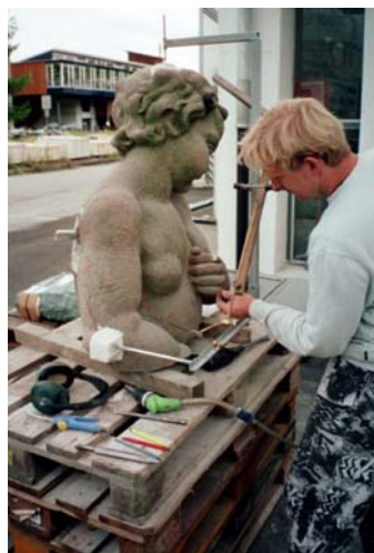
Abbildung 9: Der untere Teil der linken bekrönenden Putte des Tympanons wurde reprofiliert (links), der obere musste in der Bildhauerei von Walter Ghenzi in Uznach abpunktiert werden
