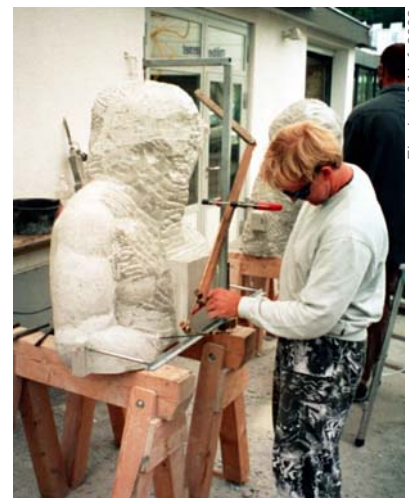
Abbildung 9: Der untere Teil der linken bekrönenden Putte des Tympanons wurde reprofiliert (links), der obere musste in der Bildhauerei von Walter Ghenzi in Uznach abpunktiert werden
