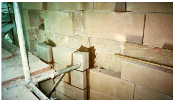
Abbildung 7: Vorbereitete Mauerlücke
