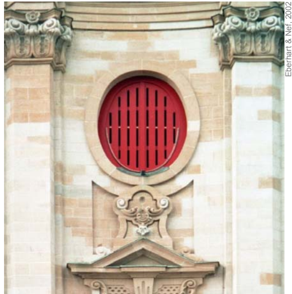
Abbildung 5: Heutige (hellgrau), bereits früher restaurierte (rötlich) und ursprüngliche Mauersteine (dunkelgrau)
