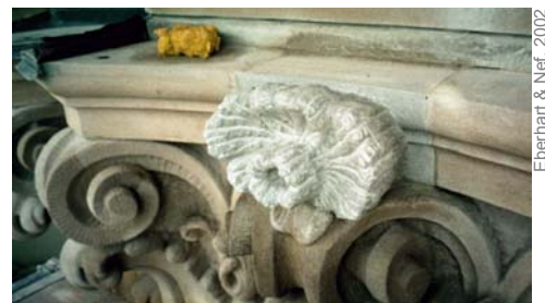
Abbildung 6: Teilersatz der Blume eines Verdachungsläufers
