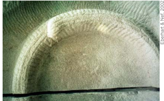
Abbildung 8: Der beschädigte rechte Teil dieses Bogens wurde reprofiliert
